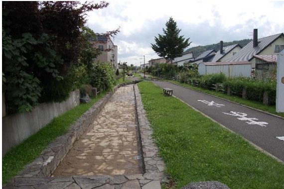
写真11 住宅街では親水の水路。美瑛川の水が濁るとこも濁った水が流れる。導水のほとんどはこの下の暗渠を通る。
