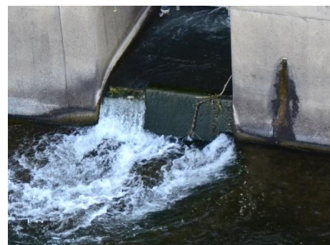
写真5 忠別川取水堰の魚道(改良前)
