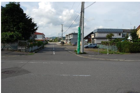
写真15 正面の道路の右側の空き地（駐車スペース）がかつての灌漑溝があった場所である。現在は暗渠になっている。
