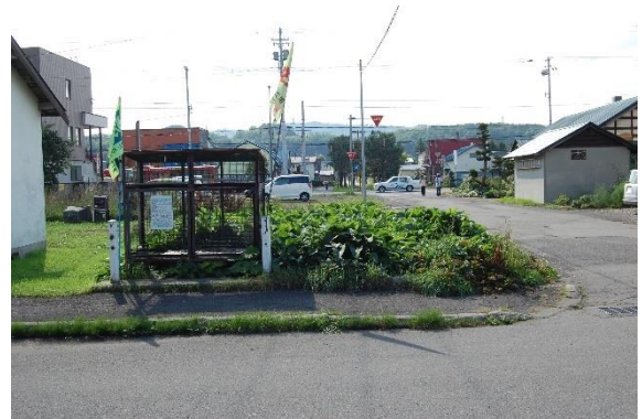
写真24 正面奥から手前に水路があった。水路を横切る道路の両側（写真正面と反対側）に幅2m弱の橋の痕跡がある。
