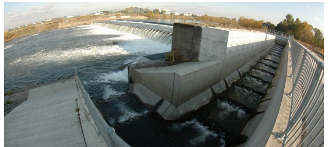
写真2 旧花園頭首工と多数のシロザケ回帰が想定される2011(平成23)年に左岸側に設置された2番目の魚道
