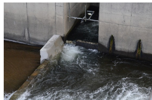
写真6 忠別川取水堰の魚道(改良後)
