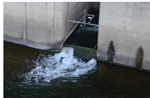
写真5 忠別川取水堰の魚道(改良前)
