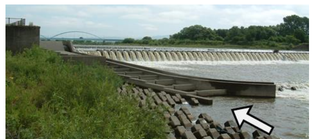
写真1 下流側から見た旧花園頭首工と2000(平成12)年に右岸側に設置された1番目の魚道
