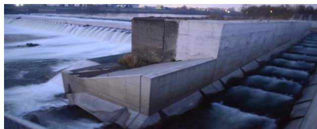
写真2 旧花園頭首工と多数のシロザケ回帰が想定される2011年に左岸側に設置された2番目の魚道
