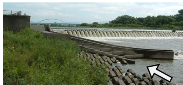
写真1 下流側から見た旧花園頭首工と2000年に右岸側に設置された1番目の魚道
