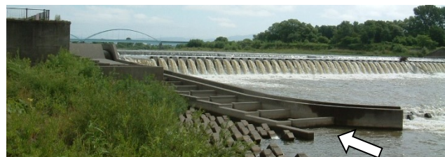
写真1 下流側から見た旧花園頭首工と2000年に増設された右岸側の魚道(写真下の矢印が魚道入口)
