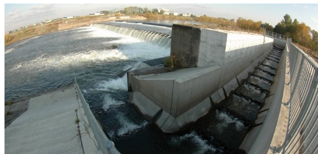
写真2 旧花園頭首工と2011年に新設された左岸側の魚道
