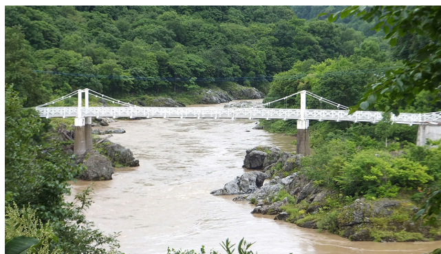
石狩川に架かる神居古潭の象徴である白亜の吊り橋
