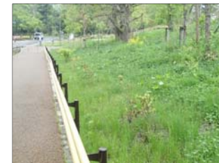
整備後 (H29.5 撮影)
