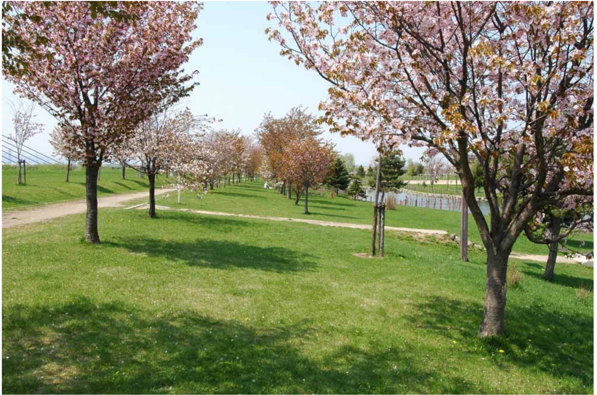
東部中央公園に近接する緩傾斜（ツインハーブ橋付近右岸上流） 法勾配8割程度（右奥は東部中央公園の池）
