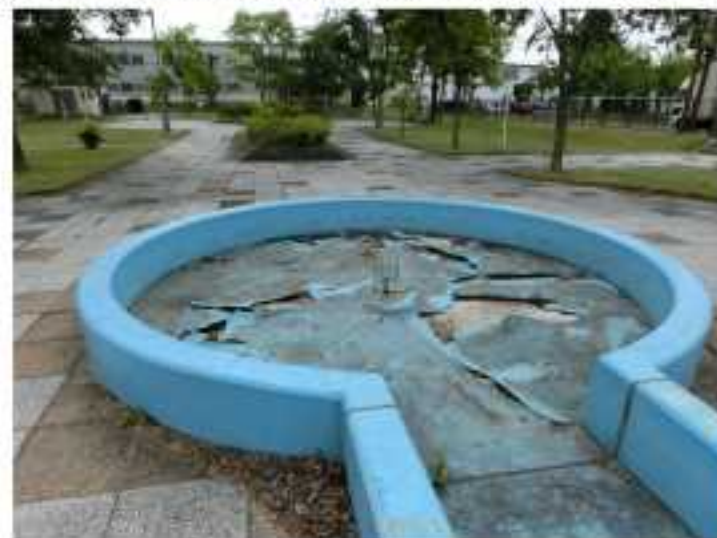
■老朽化のため休止中の噴水（日の出公園） —塩素ポンプ故障、防水シートの剥離
