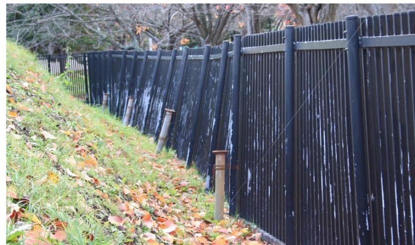
外周柵は塗装の剥離と形状の変形
