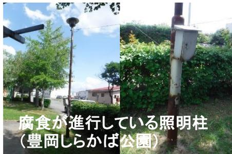
腐食が進行している照明柱
