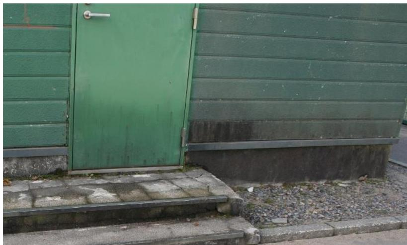
管理棟のサイディングの劣化欠損, ひび割れ
