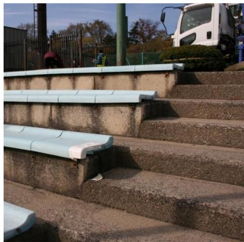
スタンドの座面の劣化, 盛土部分の崩れ
