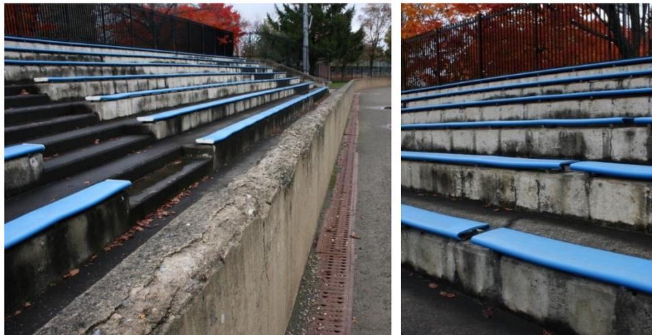
座面の変形や一部欠損、コンクリート躯体やの劣化
