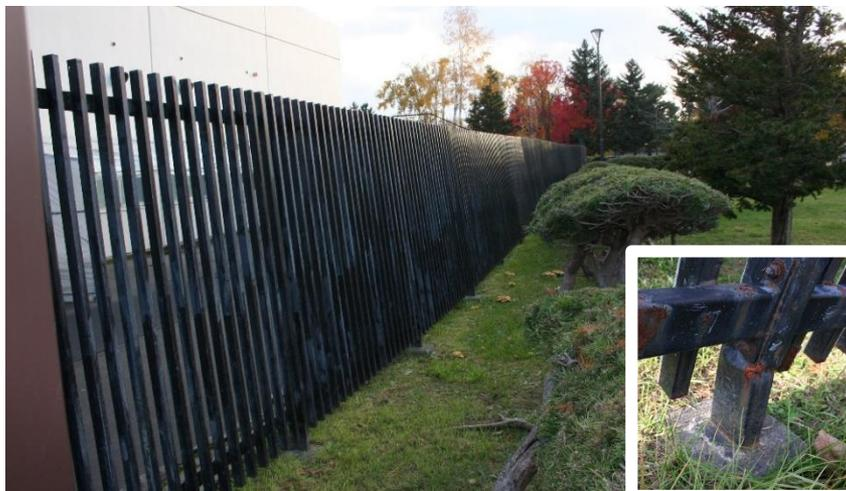
外周柵の錆による劣化，欠損や倒れこみ
