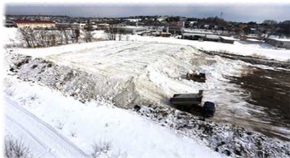
河川敷の雪堆積場
