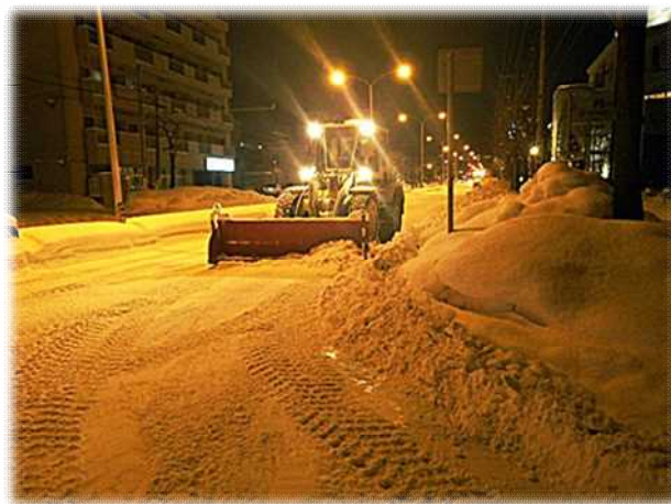
夜間の除雪作業
