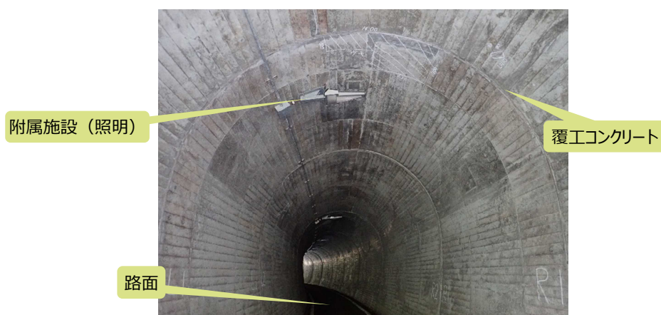
トンネルの構造例
