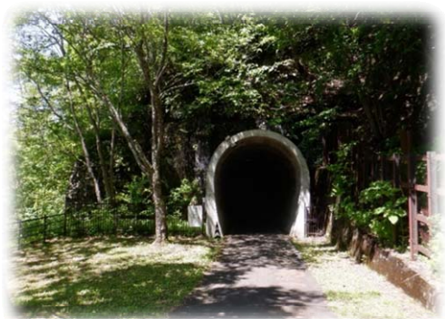
トンネル (神居古潭トンネル)
