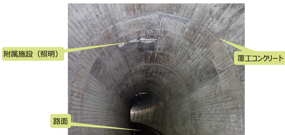
トンネルの構造例
