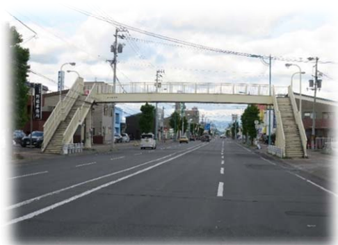
横断歩道橋 (東町歩道橋)
