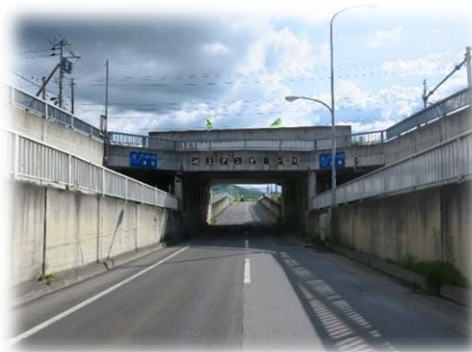
大型カルバート (近文アンダーパス)
