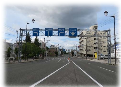
門型標識 (緑橋通2号線門型標識)
