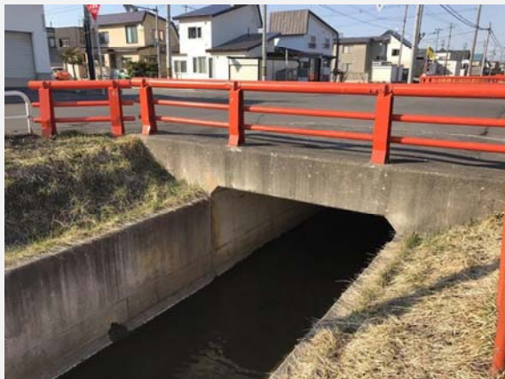
神居第 33 号橋（BOX 橋）
