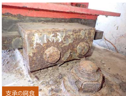
損傷の進展状況の例
