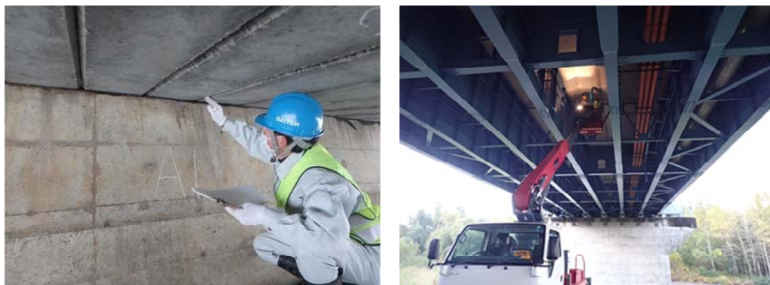
定期点検状況
