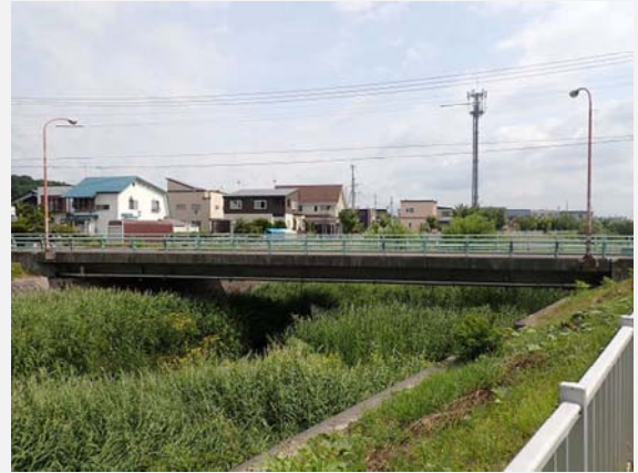
北鎮橋（主要な市道上で橋長 15m 以上）
