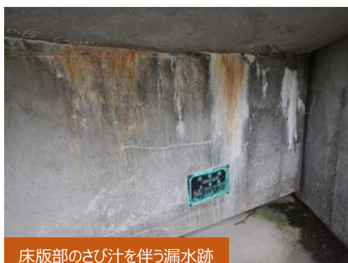
損傷の進展状況の例
