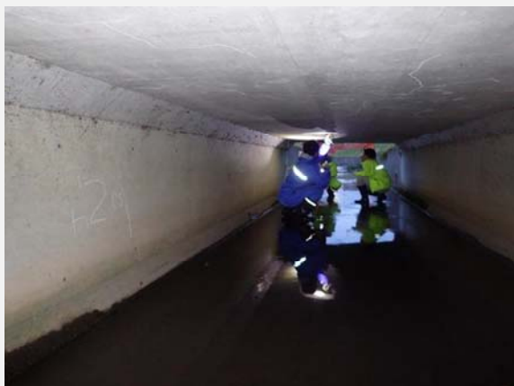
職員による点検作業状況
