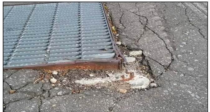
雨水枡の蓋（グレーチング）と舗装の破損
