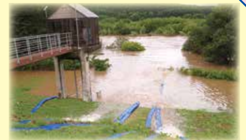
(排水ポンプによる雨水排除)
