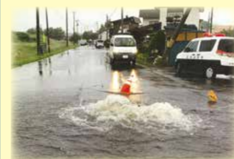
(マンホールから水が溢れている状態)
