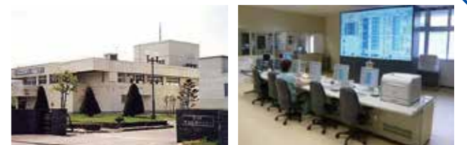
(旭川市神居町忠和にある「旭川市下水処理センター」)
