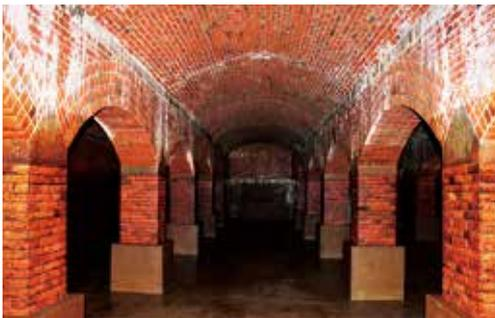
大正2年建設の「覆蓋付緩速ろ過池」。内部の壁はレンガで、現在は配水池として使用されている
