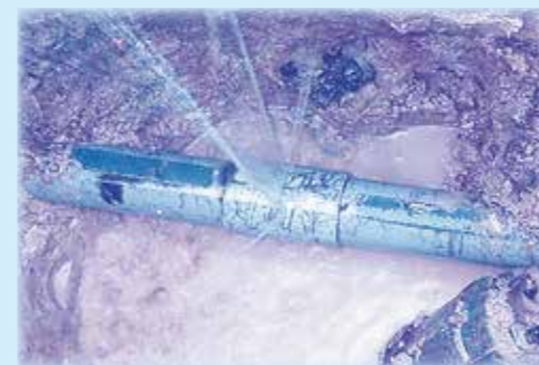
(ひび割れにより漏水した水道管)
