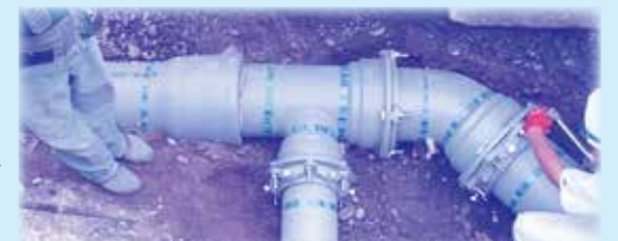
(地震に強い水道管への取替え)
