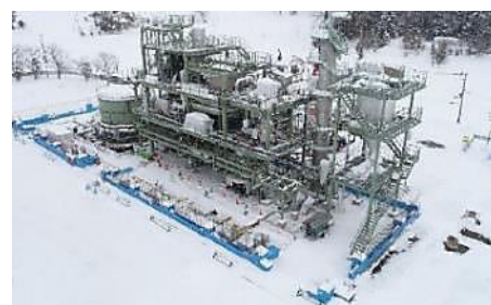
《1号污泥焼却施設の建替》 (下水処理センター)
