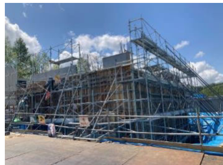
《建設中の新高砂台調整池》
