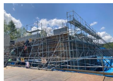
建設中の高砂台調整池
