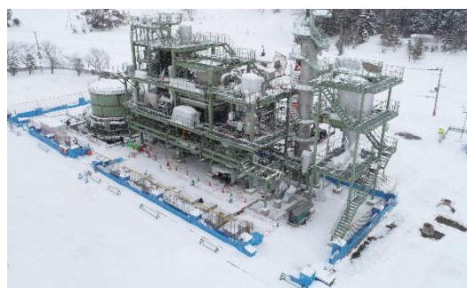
建設中の1号汚泥焼却施設
