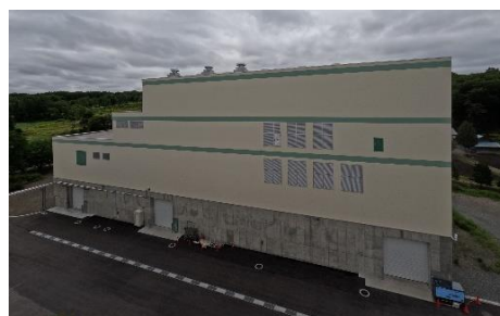
建設中の1号汚泥焼却施設
