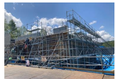
建設中の高砂台調整池
