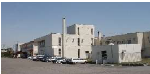
石狩川浄水場
