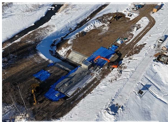
寿橋下流の樋門を改良（令和6年）
