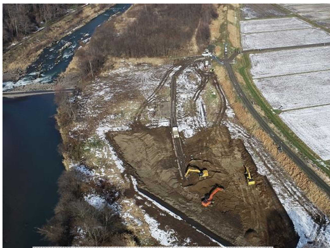
8号・9号の河道を掘削（令和6年）
