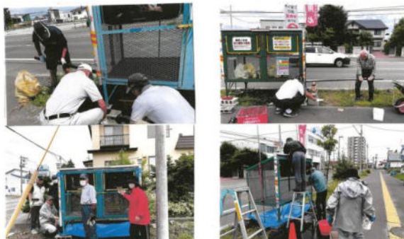
七つ星ごみステーションのリニューアル事業(6台) 作業写真 6月16日作業開始後、雨となり、作業は中断。その後、雨の降る中、作業員は各自の持ち道具で作業を進めた。6月23日まで完了して下り、その後、作業員は各自の持ち道具で作業を進めた。
