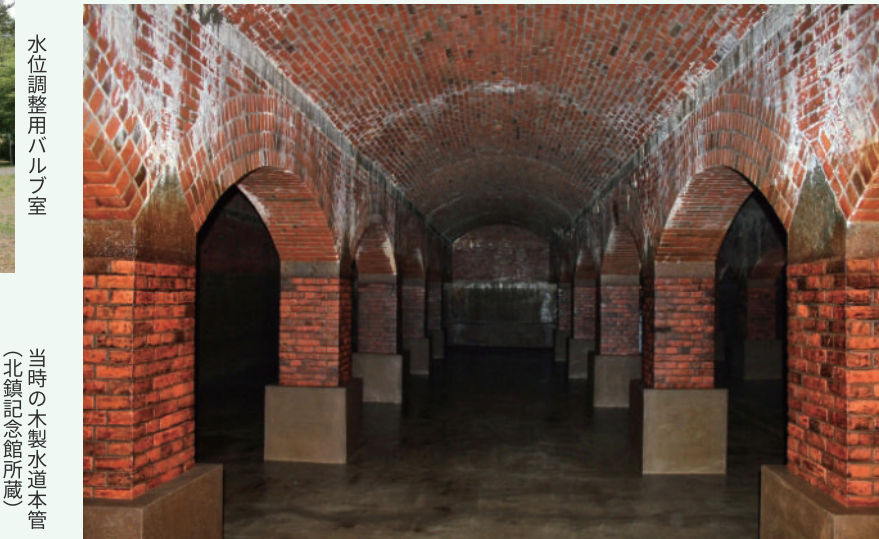
水を抜いた時の配水池内部(旭川市水道局資料)
