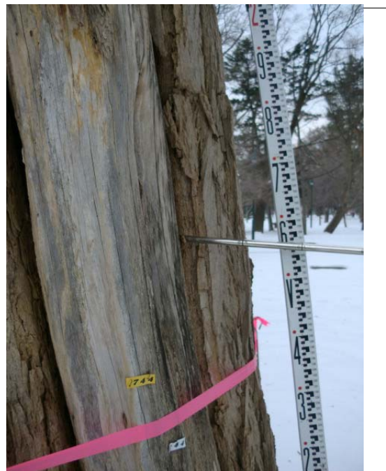
芯露出腐朽傷激大
