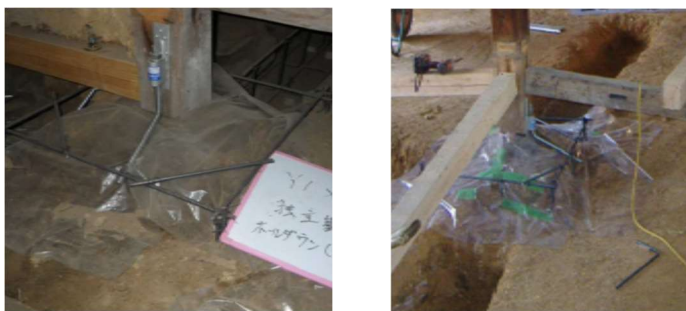
写真 6-1 独立柱の基礎補強の施工例
