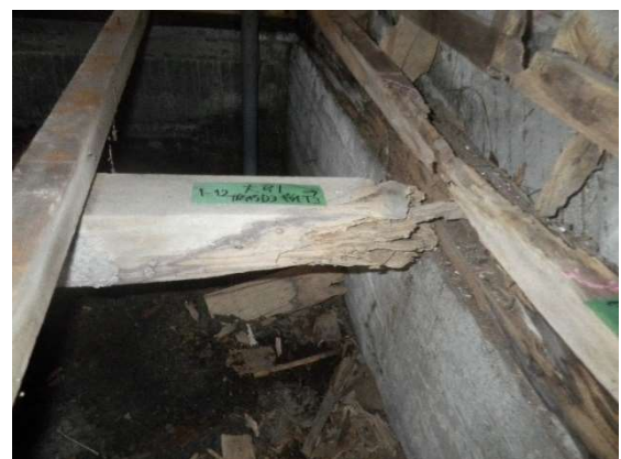
写真 4-6 解体住宅における部材の腐朽状況
