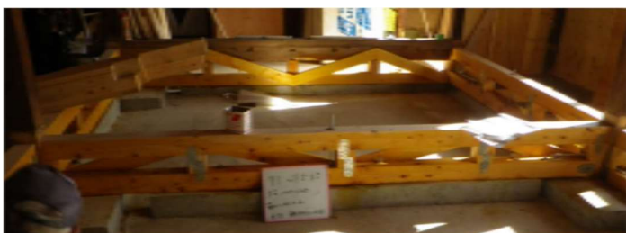
写真 6-2 床梁補強の施工例
