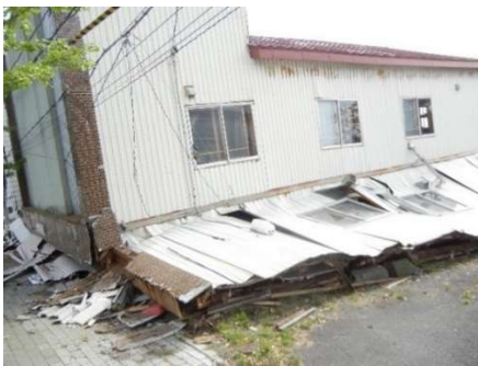
写真4-7 店舗併用住宅の倒壊被害
