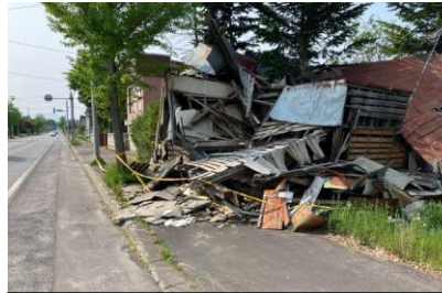
(R7.05.30) 開発局瓦礫撤去前
