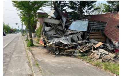
(R7.05.30) 開発局瓦礫撤去後
