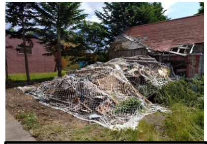
(R7.06.24) 飛散防止ネット養生後
