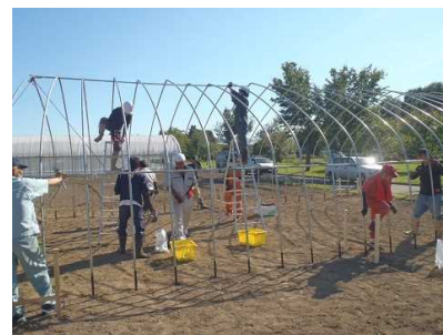
パイプハウス施工研修
