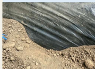
7月18日（敷設71日後）
