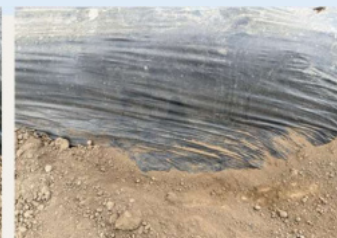
10月1日（敷設146日後）
