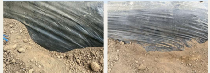
7月18日（敷設71日後）
