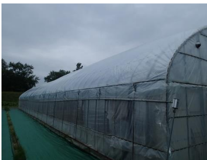
図2 空気膜二重フィルムハウス
