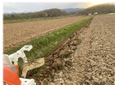
排水性改善のための溝掘作業
