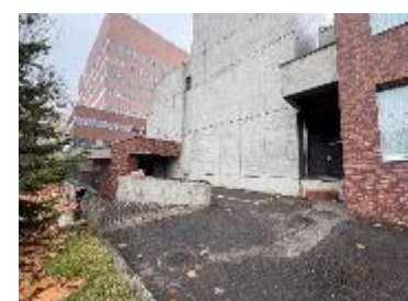
小ホール・展示室搬出入口
