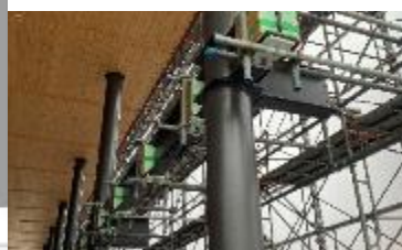
ピロティ柱上部構造躯体
