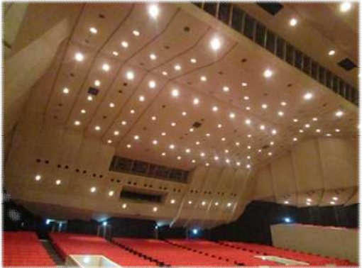
④大ホール天井
