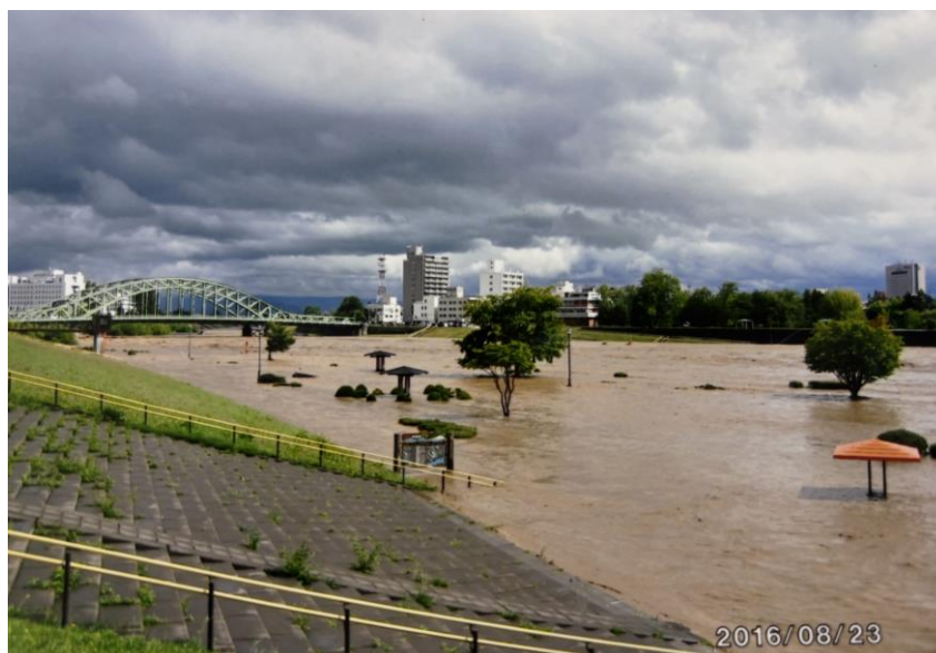
【参考】平成28年8月に発生した石狩川河川敷の水没
