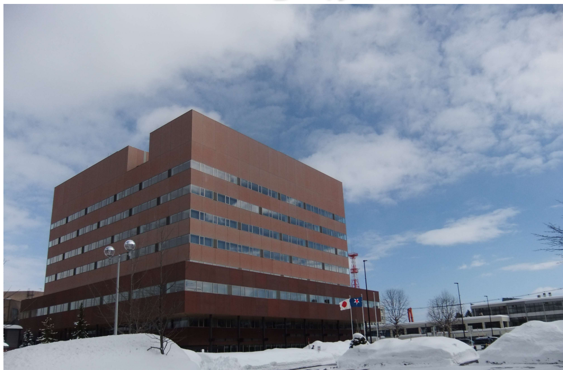
旧庁舎の解体整地が終わり駐車場として整備された新総合庁舎
