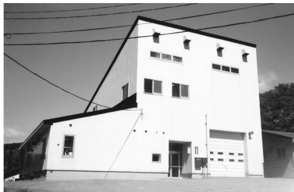
汚水処理施設
