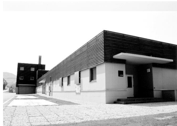
汚水処理施設
