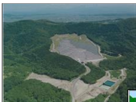
旭川市廃棄物処分場 (平成15年6月)
