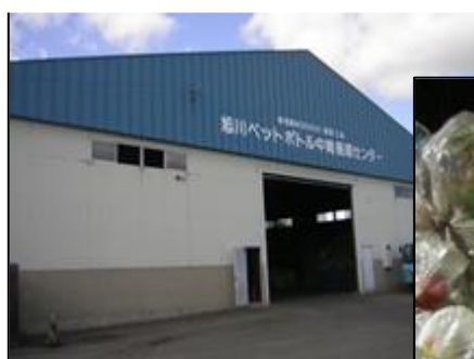
旭川ペットボトル 中間処理センター
