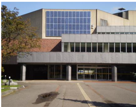
図 2-2 市民文化会館の太陽光パネル
