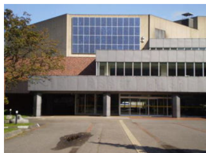
図 2-3 市民文化会館の太陽光パネル
