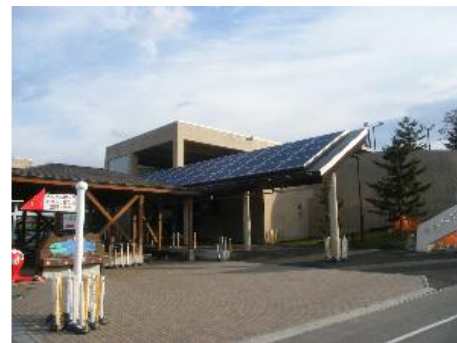
図 2-4 旭山動物園の太陽光パネル
