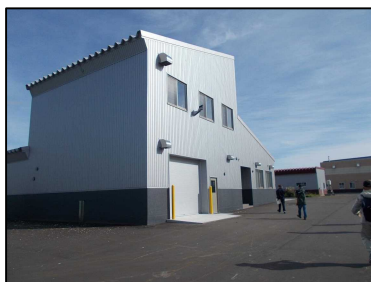
浸出水処理施設
