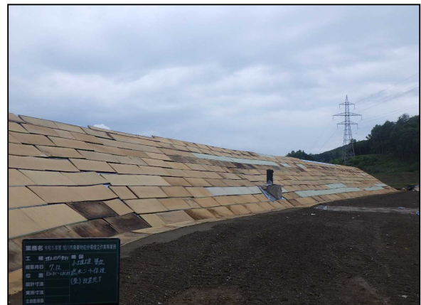
遮水シート防護(廃たため)
