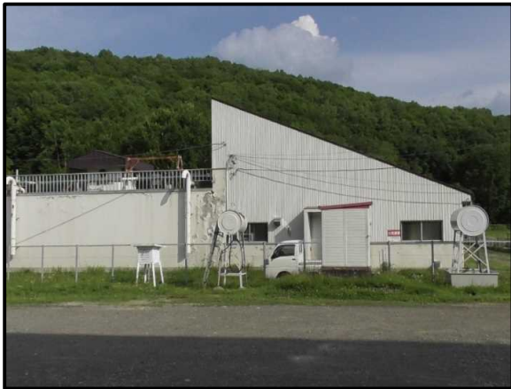
水処理施設① 外観
