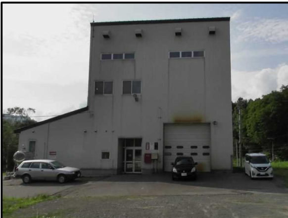
水処理施設② 外観
