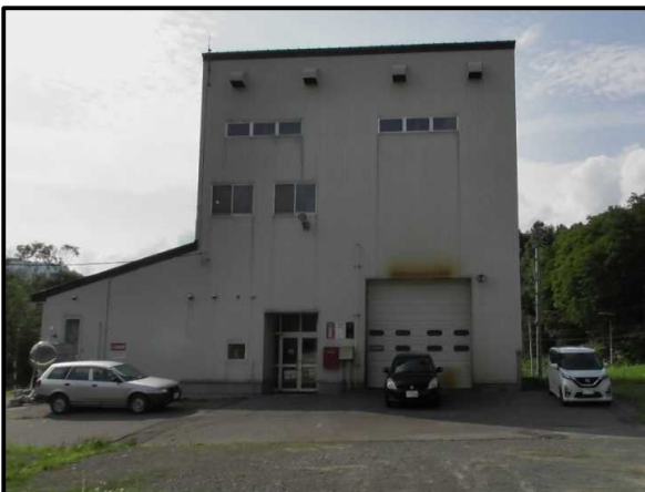
水処理施設② 外観
