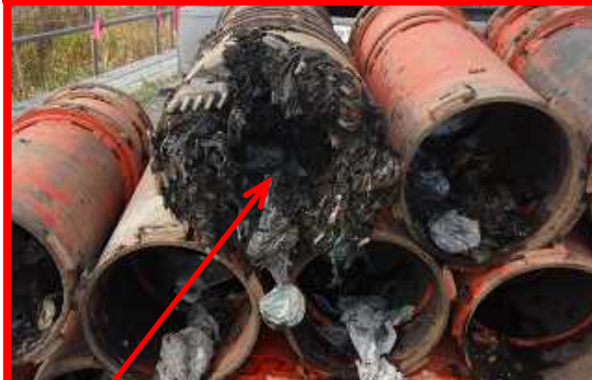
廃棄物によるケーシング管の閉塞状況
