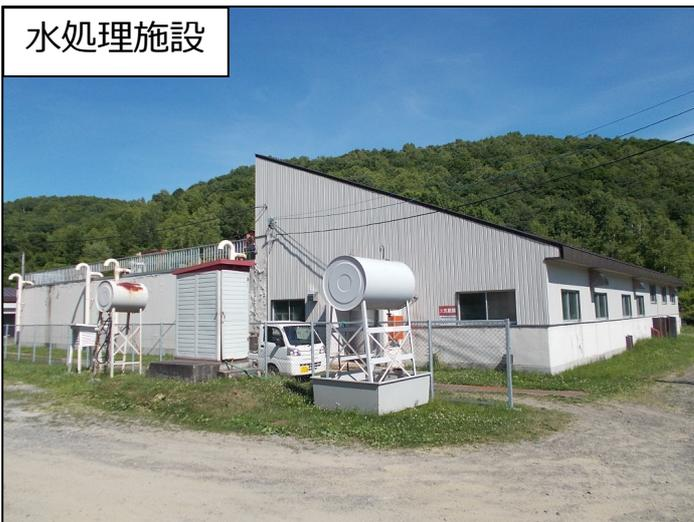
埋立地に降った雨を水処理施設で高度処理後、河川に放流していましたが、令和元年10月に放流水質の自主基準値を見直したことから、現在は塩素滅菌処理のみ実施しています。
