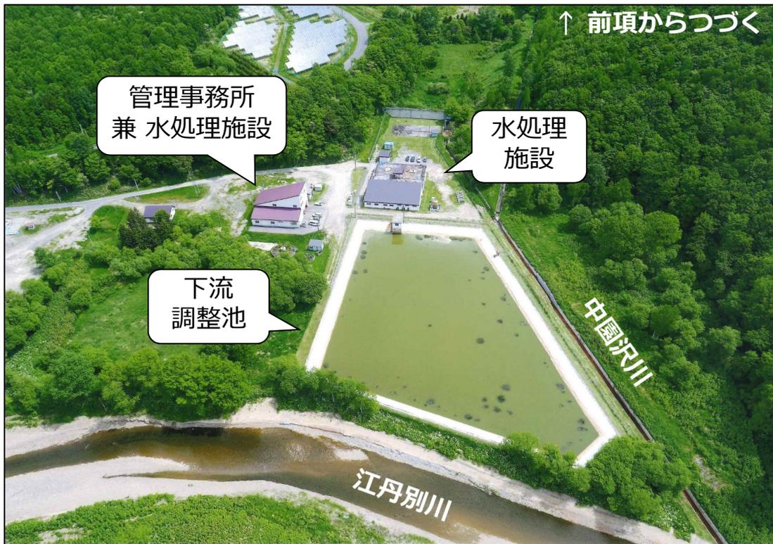
埋立完了から18年が経過し、現在は廃止に向けて「浸出水」の処理と「発生ガス」の監視を実施しています。
