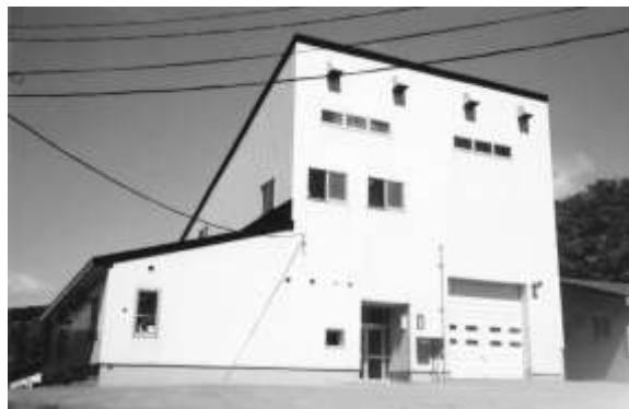
汚水高度処理施設
