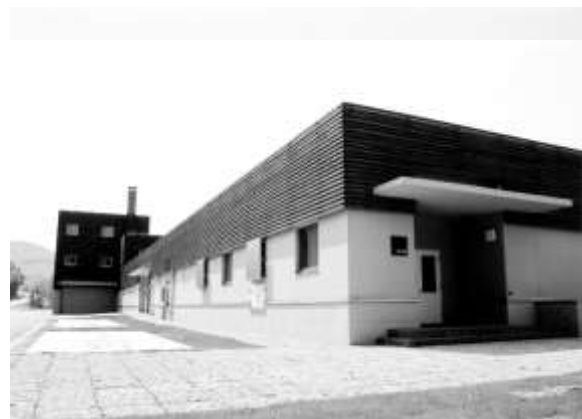
汚水処理施設
