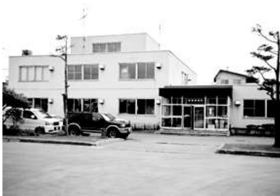
クリーンセンター管理事務所
