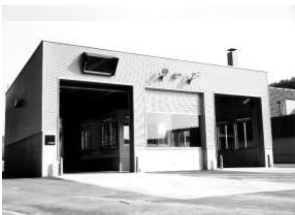
廃棄物処分場料金所
