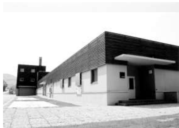
汚水処理施設
